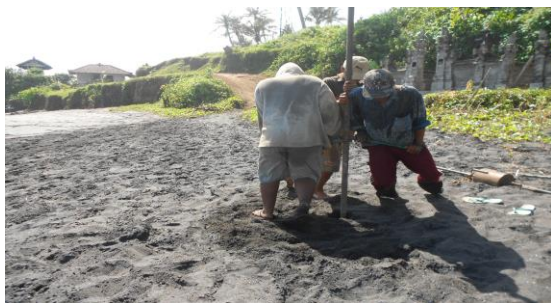
Gambar 6 Pekerjaan Bor yang dilakukan Arus dan Pasang Surut
