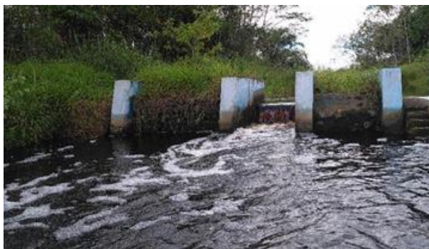
Gambar 7 Bagian pelimpas pada drainpile
