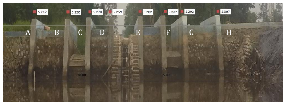
Gambar 1 Elevasi beberapa titik pada tubuh drainpile hasil pengukuran menggunakan waterpass (satuan dalam meter)
