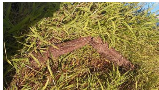
Gambar 3 Papan skot balok yang rusak
