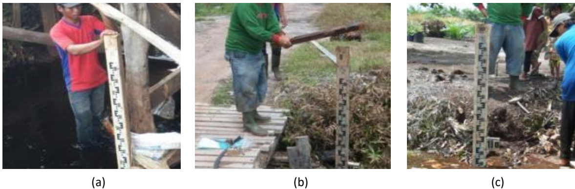
Gambar 14 Pemasangan rambu ukur pada saluran (a) sekunder, (b) kuartar dan (c) tersier
