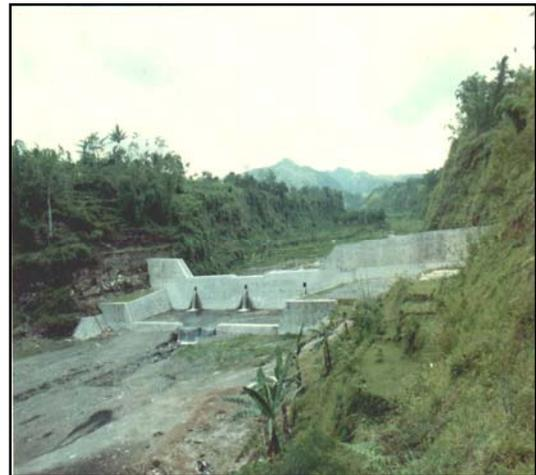
**Gambar 12** Bendung Penahan Sedimen di K.Semut
