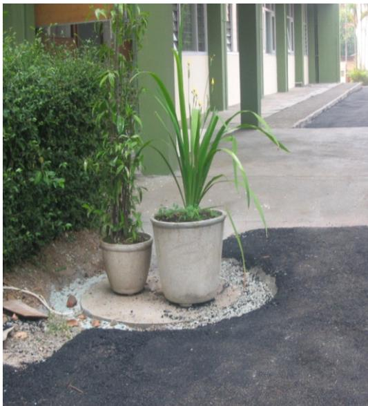
Gambar 3 Prototip Sarana Resapan Air Sangat Sederhana (SaRASS) di Balai Lingkungan Keairan.
