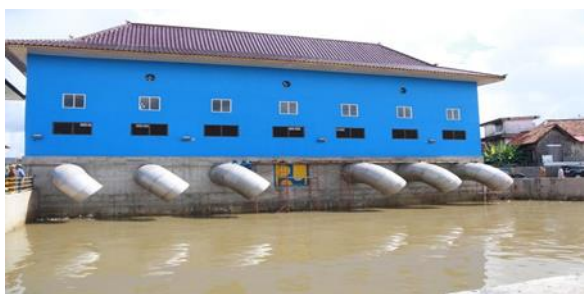
Gambar 2 Rumah Pompa Sungai Bendung
